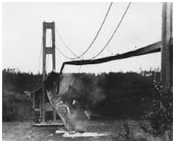
شکل ۱.۴: فرو ریختن پل تاکوما ناروز در اثر ارتعاش ناشی از باد، این پل در ۱ ژوئیه سال ۱۹۴۰ افتتاح شد و در ۷ نوامبر سال ۱۹۴۰ فرو ریخت [۱۰۸].
